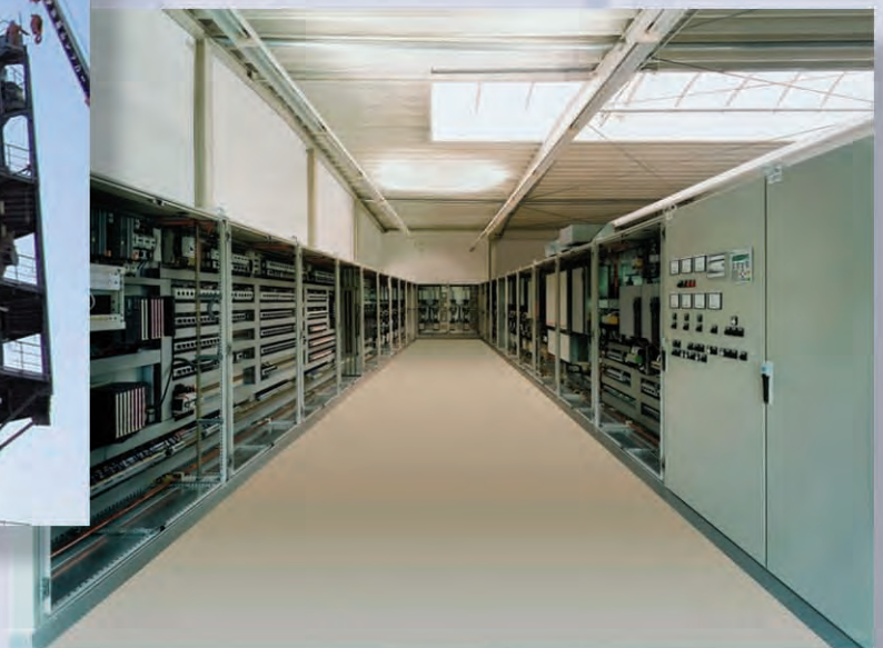
Niederspannungsschaltanlagen
