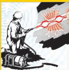
TRÄNKEN, KUNSTHARZ- UND ZEMENTVERPRESSEN WATER & RESIN INJECTION, GROUTING
